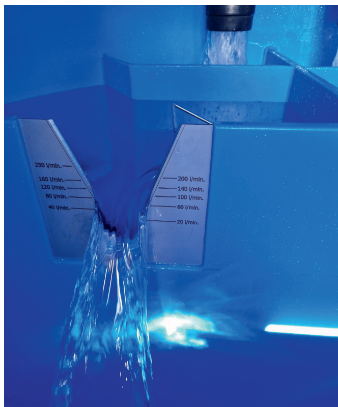
Intérieur des nouvelles chambres des sources de Trogne (2024)
