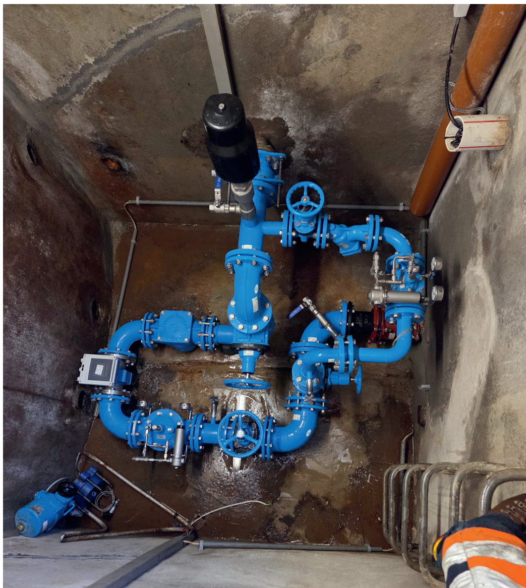
Suppression du réservoir de Saint-Martin et pose d'un By-pass (2025)
