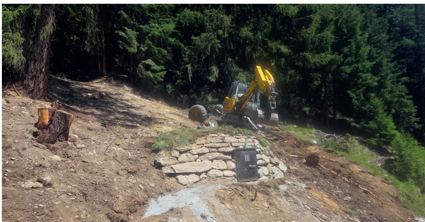
Remplacement de la chambre de captage de chépitieu (2025)
