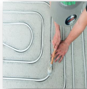
Chauffage de sol avec fraisage
